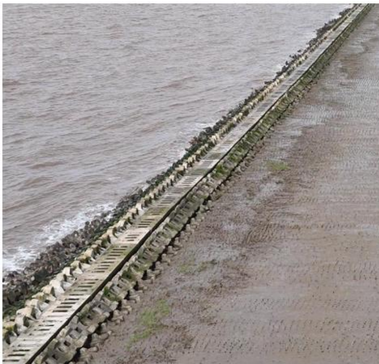
图 2.4-9 海水塘岸段消浪坝修复后成效
