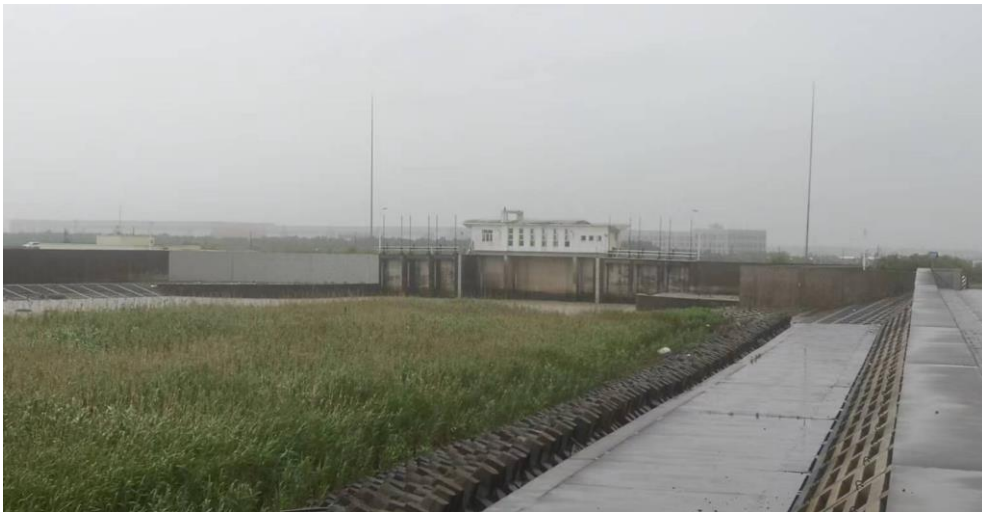
图 5.1-14 老薛家泓闸现状照片
