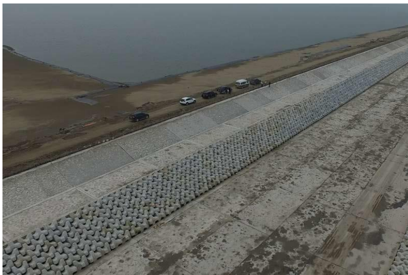
图 5.1-10 N1 库区东堤现状照片
