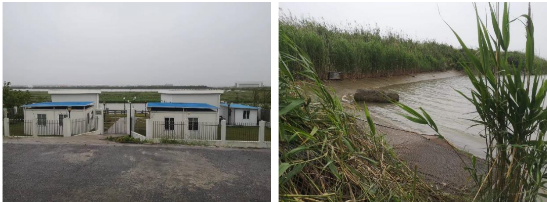
图 5.1-18 商飞排水涵闸应急排口现场照片
