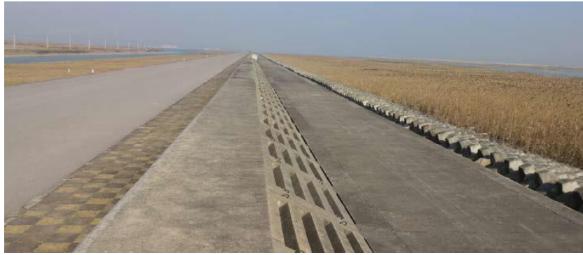
图 5.1-8 浦东机场 3#库区南堤现状照片
