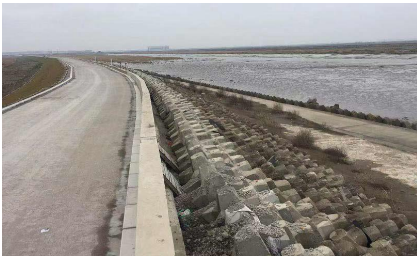
图 5.1-12 N1 库区北侧堤现状照片
