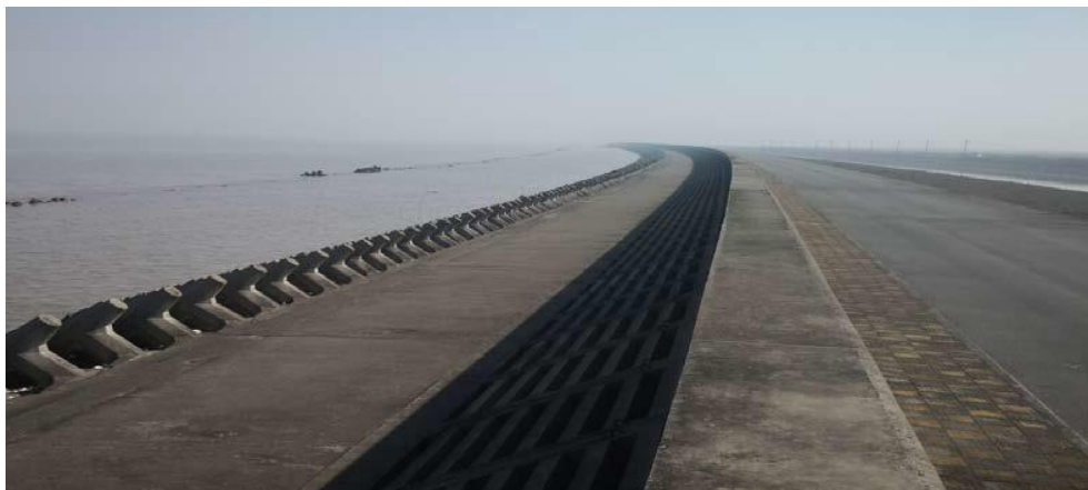
图 5.1-6 浦东机场 3#库区东堤现状照片
