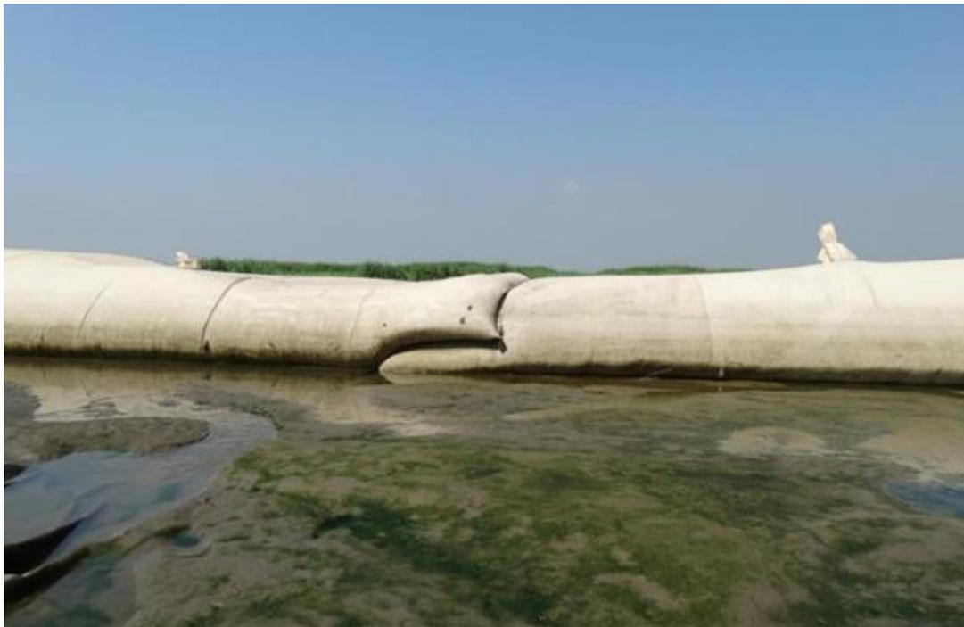
图 3.2-3 外围堰（A 型）接缝位置处理类似工程现状照片
