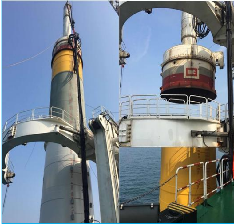
图 1.4-7 液压锤沉桩施工
