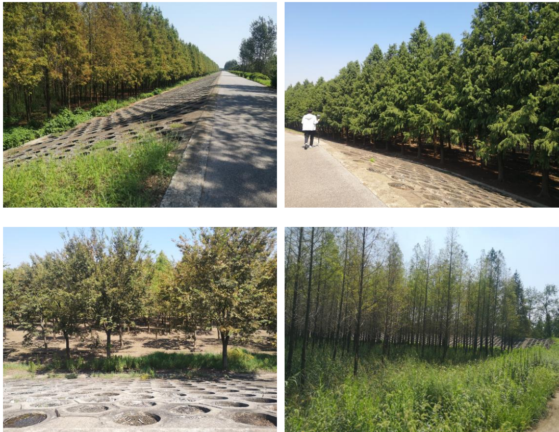
图 2.1-15 界河西塘现场照片
