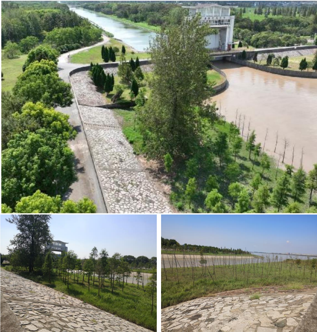
图 2.1-12 庙港北闸现场照片
