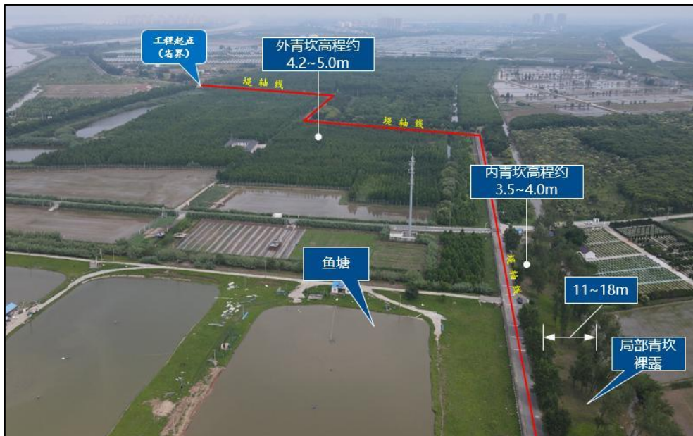
图 4.1-1 省界~庙港北闸段海塘内外侧现状
