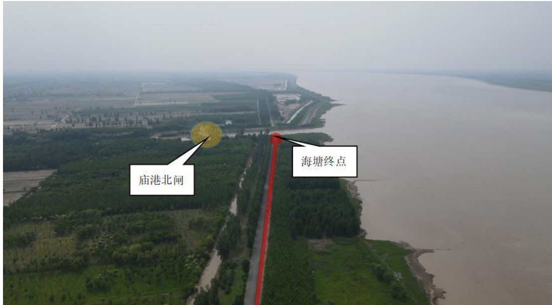
图 2.1-7 北庙东塘西半段航拍照片
