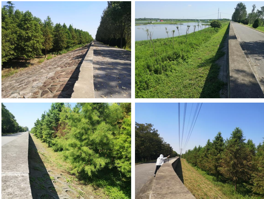
图 2.1-9 北庙东塘现场照片
