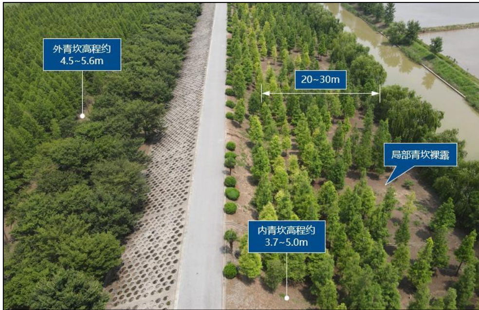
图 4.1-2 界河西塘内外侧现状
