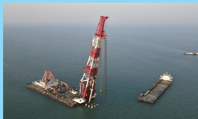
海上观测平台打桩作业
