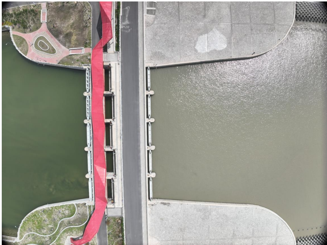
图 5.1-5 泖马河出海闸（2025 年 4 月 10 日航拍）
