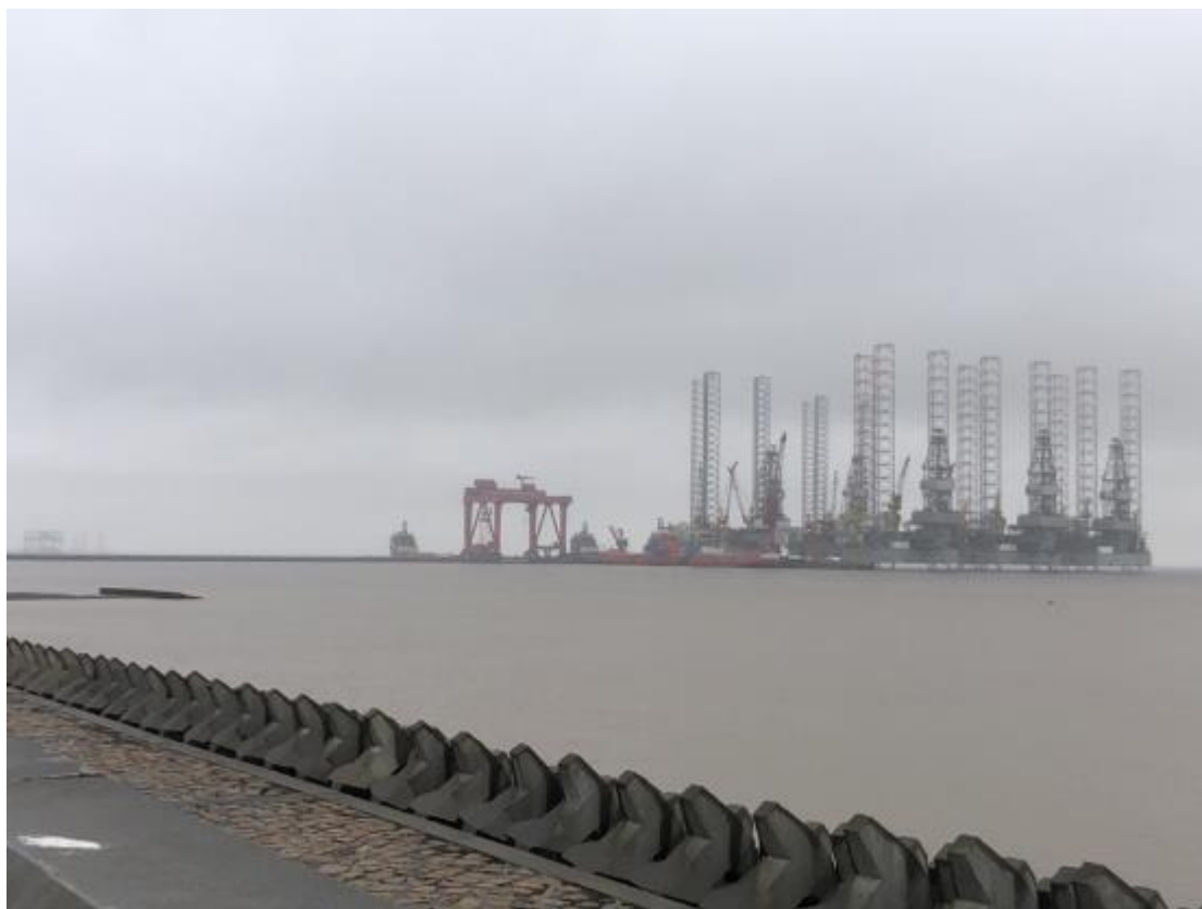
图 5.1-3 临港新城作业区码头
