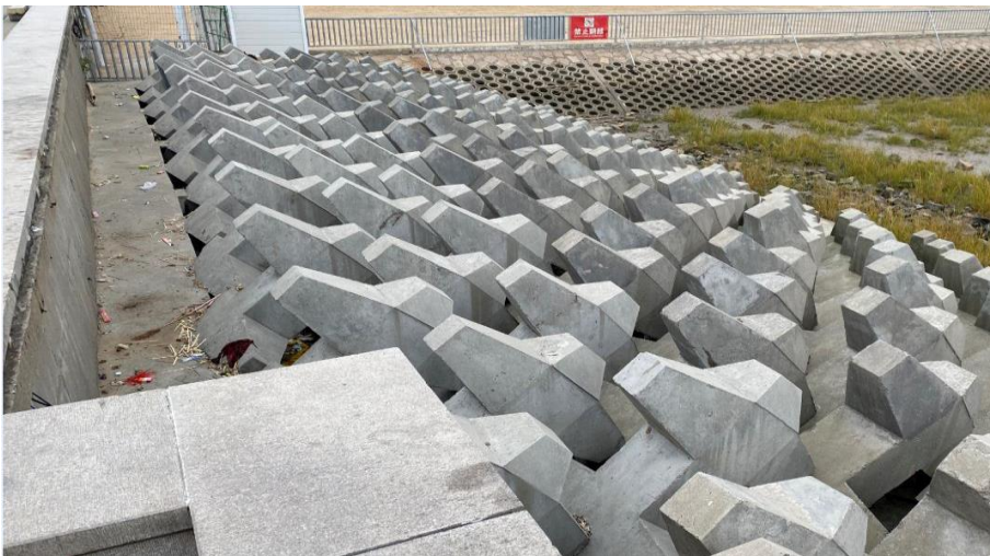
图 5.1-4 海塘堤前现状情况
