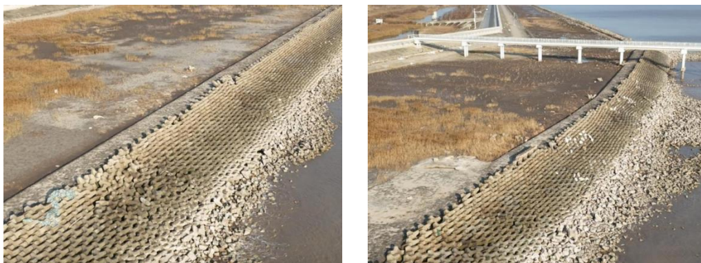
图2.2-5 现状消浪坝情况
