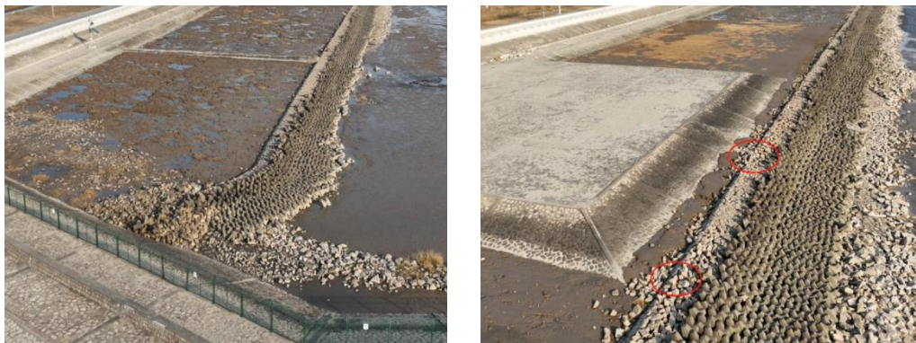
图2.2-2 消浪坝起点以东现状
