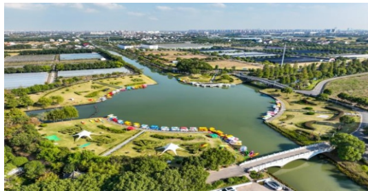
浦东新区五灶港综合整治项目
