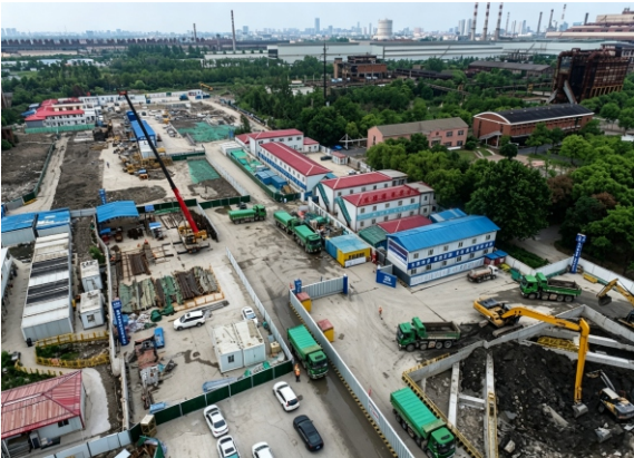
上海市轨道交通18号线二期工程 水土保持无人机巡查
