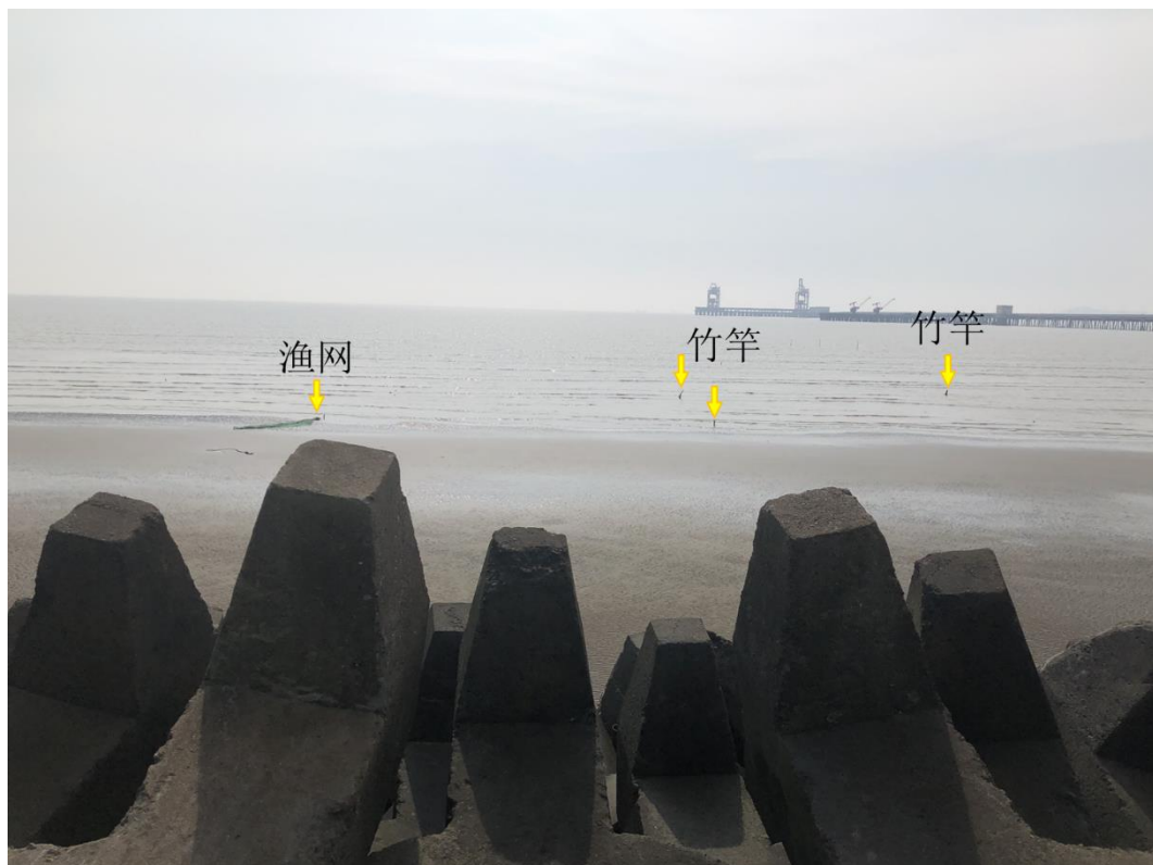
图 5.1-2 取排水管道登陆点附近
