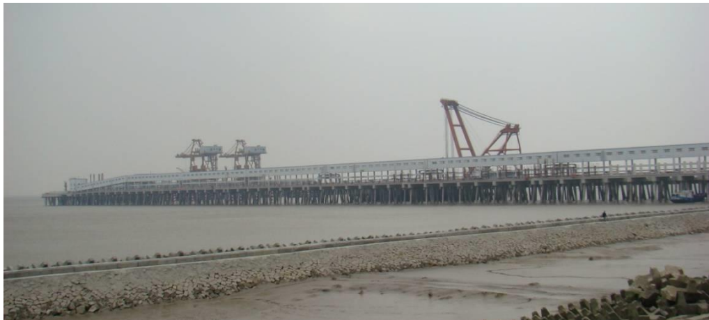
图 5.1-5 上海化工区化学园区氯碱公司码头
