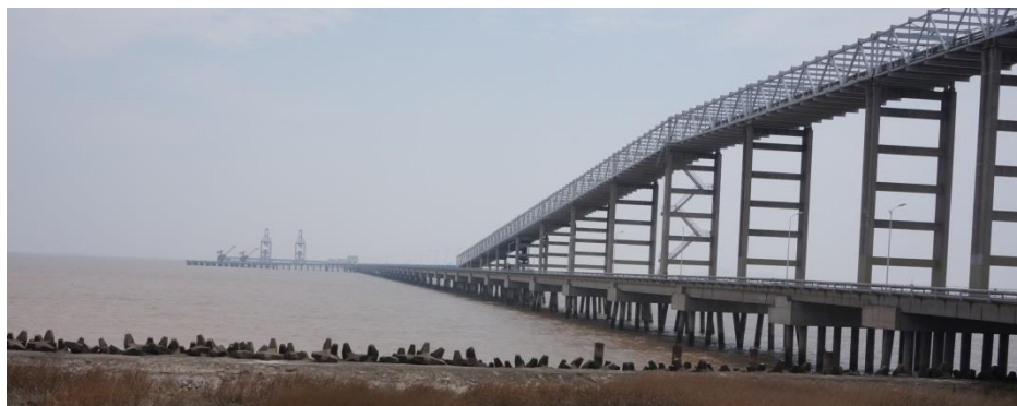
图 5.1-3 漕泾电厂煤码头
