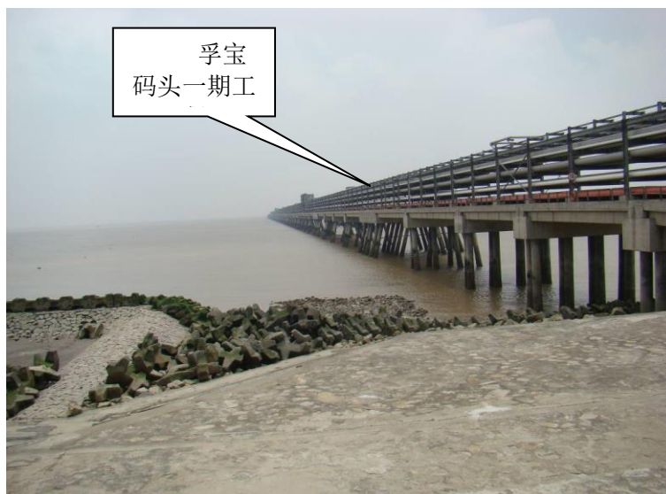
图 5.1-4 上海化工区化学园区孚宝码头一期工程
