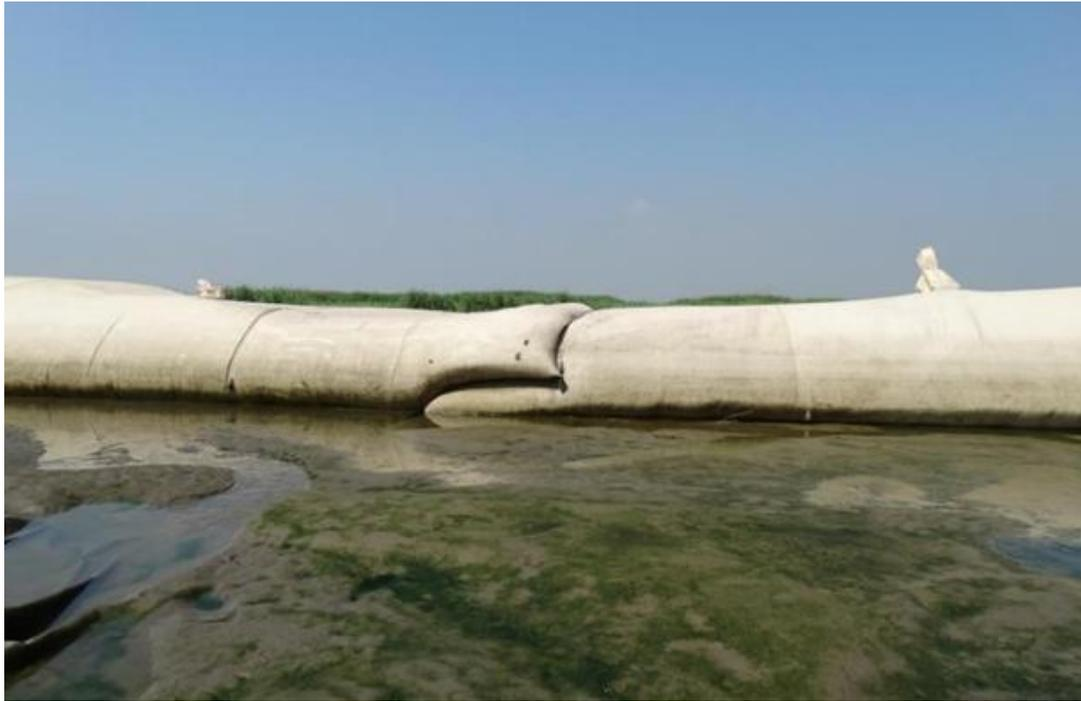
图 2.1-7 外围堰（A 型）接缝位置处理类似工程现状照片
