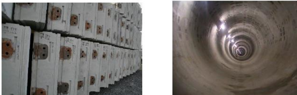
图1.2-8 铸铁手孔衬砌及成型隧道
