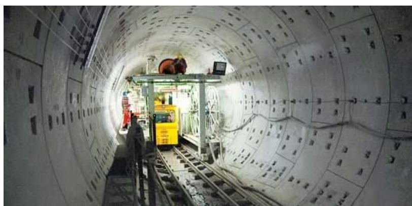
图1.2-7 盾构法施工衬砌
