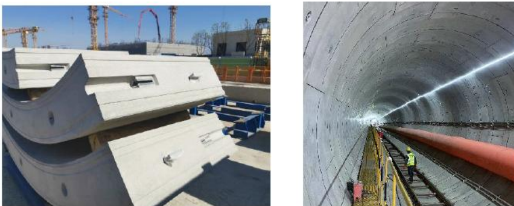
图1.2-9 新型快速连接件衬砌及成型隧道
