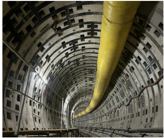
隧道成型照片（5200mm 管片外径）
