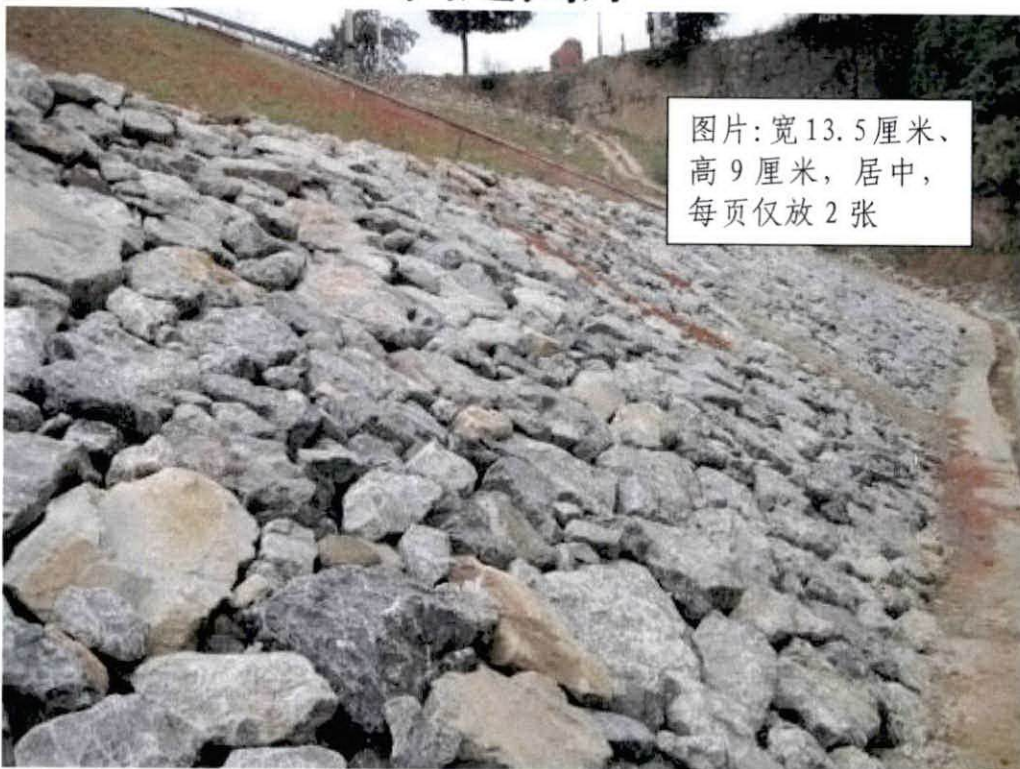
质量管理图 1-1 排水棱体干砌块石砌筑质量不符合要求，排水棱体砌筑全貌
