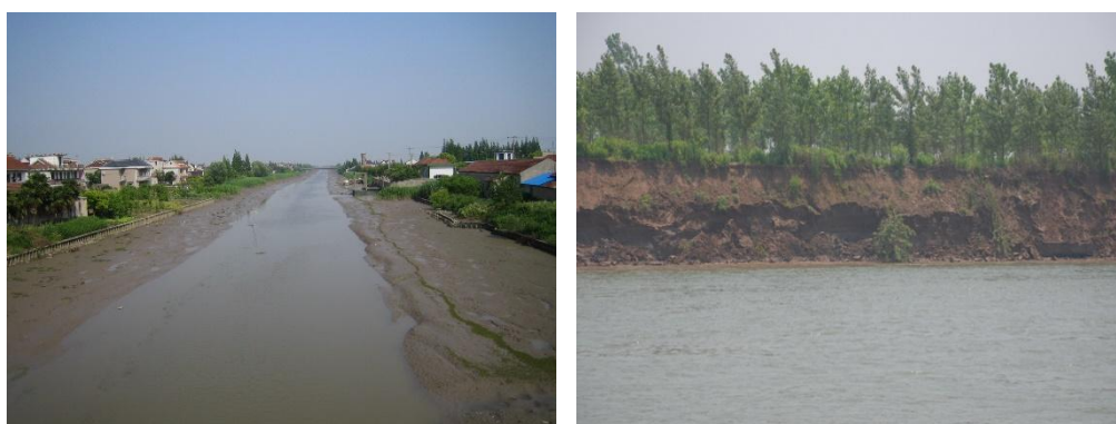
图 4.7 环岛运河南段（近港沿公路、近老激港）河道水土流失情况
